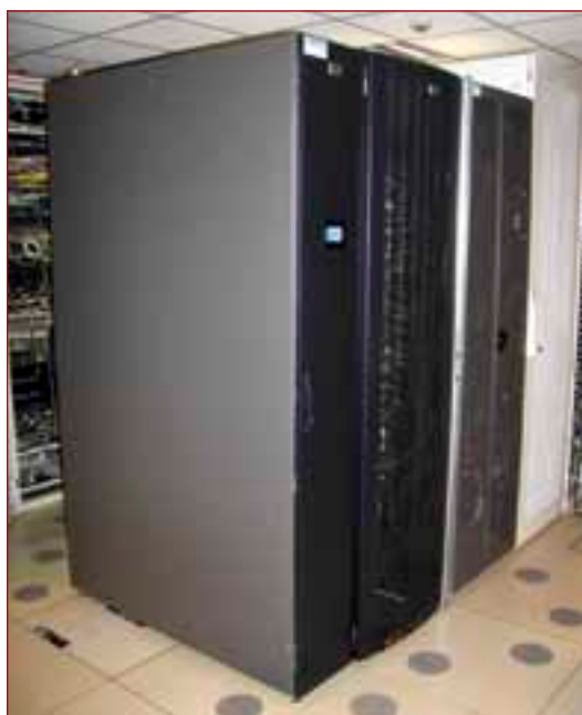
Szuperszámítógép a HP zárt klimatikus rackszekrényében
